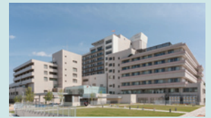
一宮市立市民病院外観
